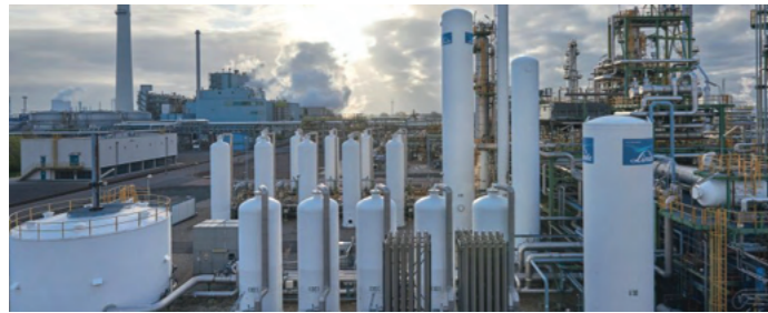
그림 40: 수소 생성을 위한 증기 메탄 개혁 시설에 설치된 PSA 유닛. 13개의 작은 원통형 용기는 흡수성 침대가 장착된 PSA 기동입니다. 이미지 제공: 린데 엔지니어링
