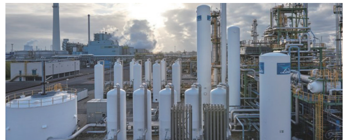
図40: 水素製造を行う水蒸気メタン改質施設に設置された PSA 装置。13本の小型円筒形容器は吸着剤層が内蔵された PSA 塔。リンデエンジニアリング社提供。
